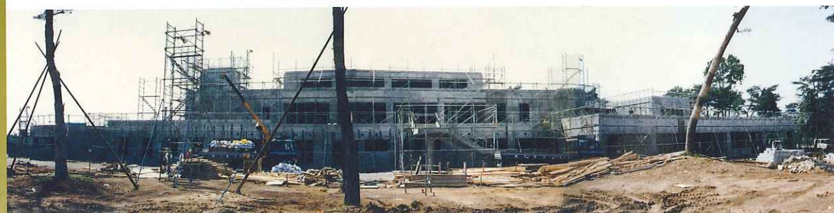
クラブハウス工事
