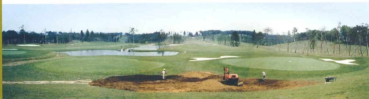
9番ホール工事
